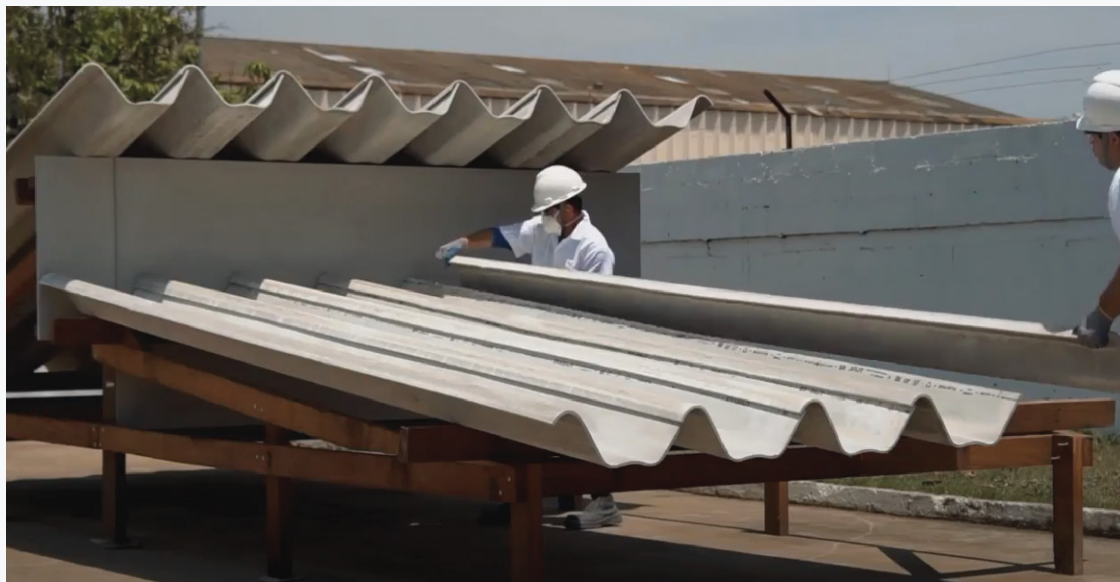
Imagem: Cobertura de grandes vãos
